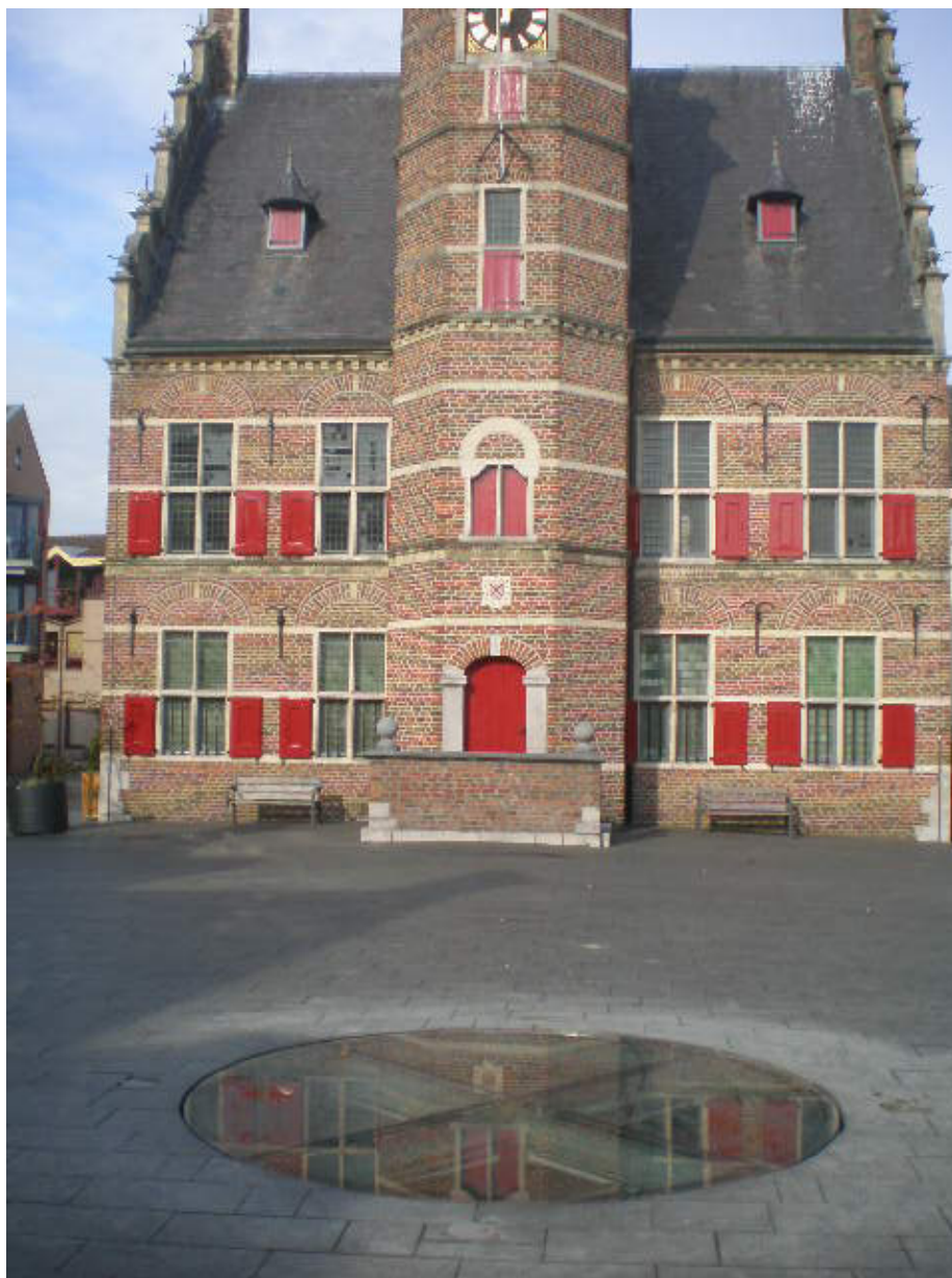
Verlichte en verwarmde afdekking waterput, markt Gennep
