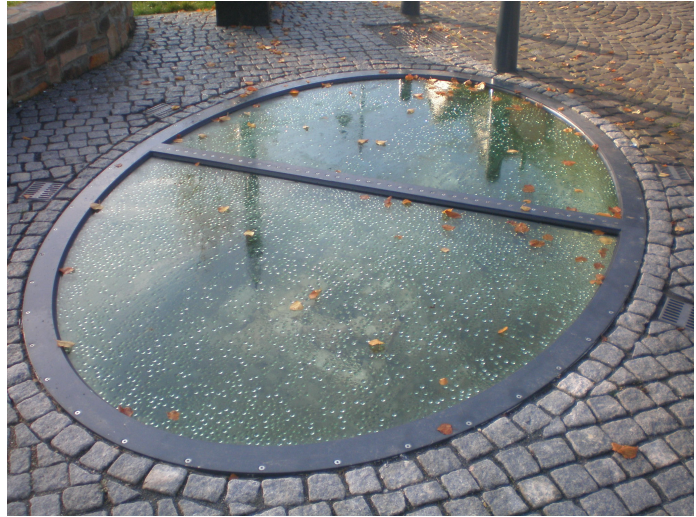
WATERPUT JABEEK - CONSTANT VOL MET CONDENS EN AMPER DOORZICHT ( = GÉÉN IQ GLAS )
