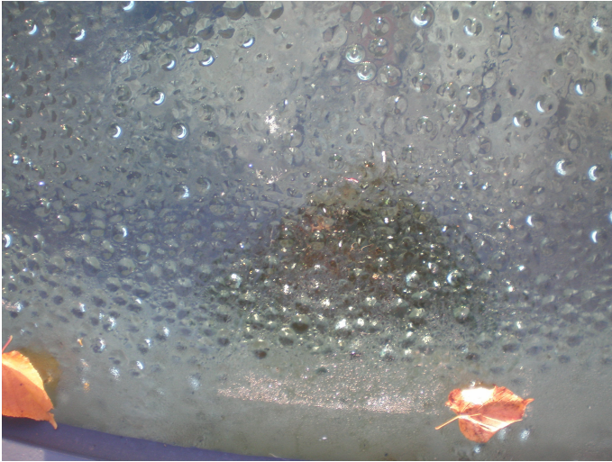
WATERPUT JABEEK - CONSTANT VOL MET CONDENS EN AMPER DOORZICHT ( = GÉÉN IQ GLAS )
